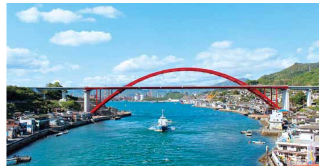
第二音戸大橋(平成25年3月27日開通)
