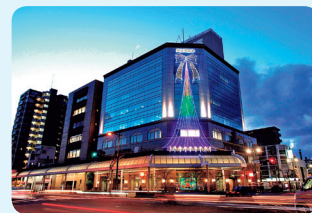
本店本館壁面へイルミネーション設置 (12月1日)
