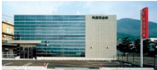
川尻支店 新築移転オープン
