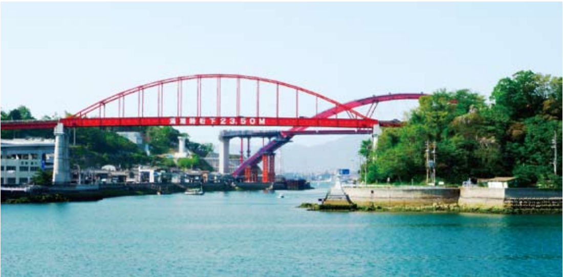
音戸の瀬戸 奥に見えるのは建設中の第2音戸大橋（平成25年春 開通予定）
