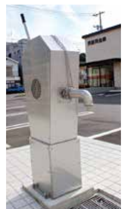
安芸津支店駐車 場内の防災井戸
