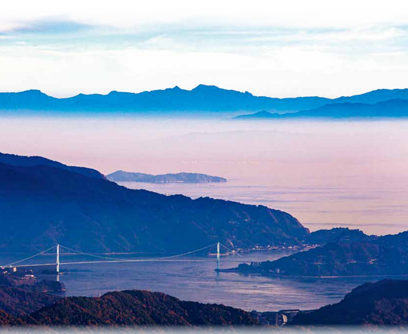
安芸灘大橋(呉市)
